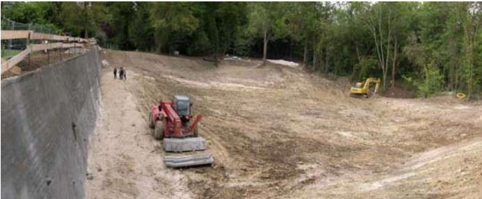
Chantier avant la réception
